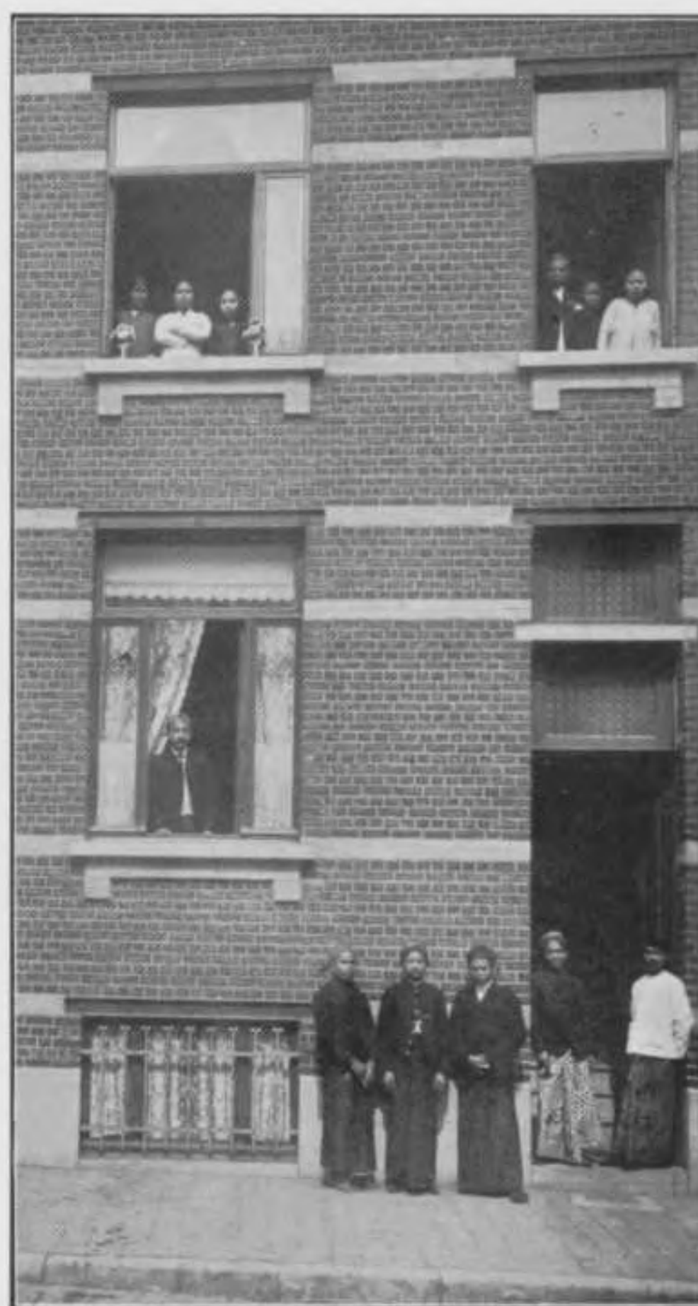
FIG. 9. WONING DER INLANDSCHE NIJVEREN. RUE SCHOOL- GAT 14. IXELLES.
